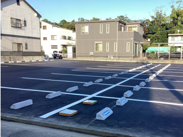
● 某駐車場 舗装工事
