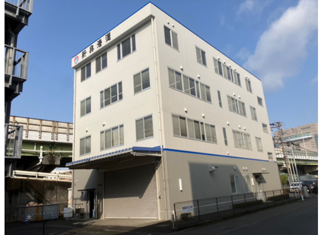
● 某事務所 屋上・外壁改修工事
