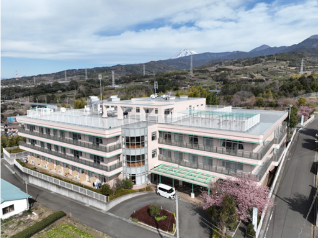
● 某老人養護施設 屋上・外壁改修工事
