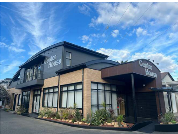
● 某住宅展示場 事務所全体改修工事
